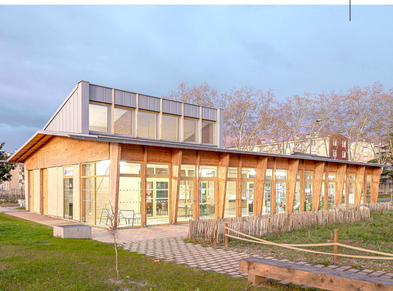
Façade finale vitrée au sud et ouvrant sur le jardin
