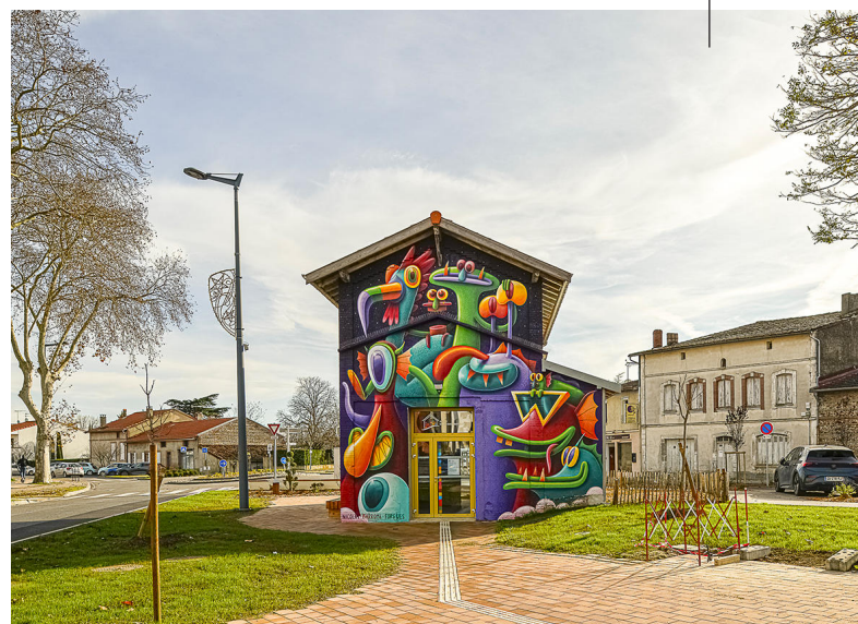
Ancienne maison du garde-barrière et sa fresque emblématique réhabilités
