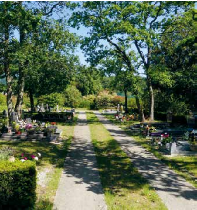
Allée avec bandes de roulement en béton et bande centrale enherbée, Cléon.
