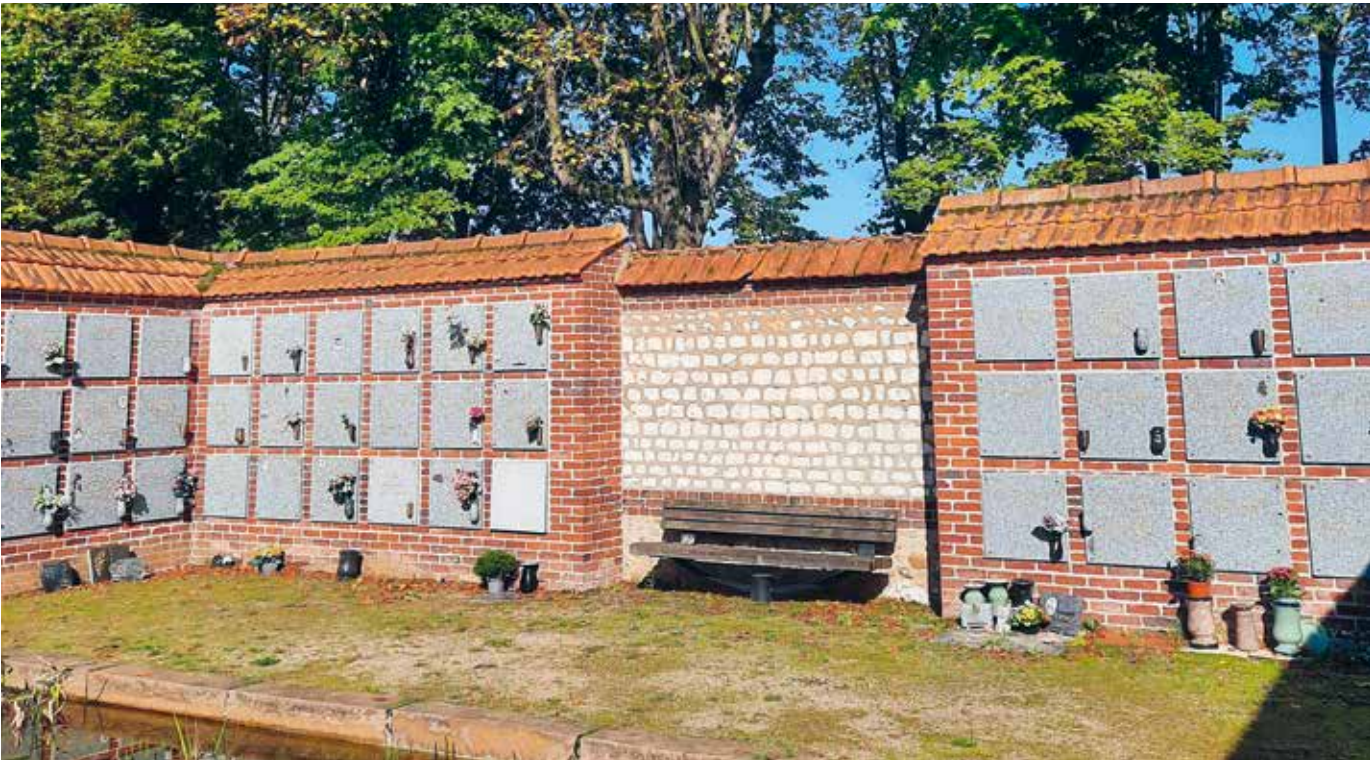
Lorsque des murs dessinent l'enceinte du cimetière, ils peuvent être valorisés en y intégrant des niches afin de composer un columbarium. Sotteville-lès-Rouen.
