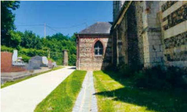
AVANT : Allée principale initialement en graviers. APRÈS : la largeur a été recalibrée et recouverte de béton désactivé. Les espaces latéraux engazonnés. Un caniveau pavé collecte les eaux de toitures, Fontenay.
