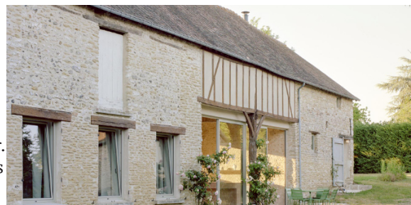
Ferme réhabilitée à Hécourt Credit photo : Maxime Delvaux
