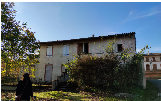
Façade arrière de l'ancien presbytère AVANT réhabilitation
