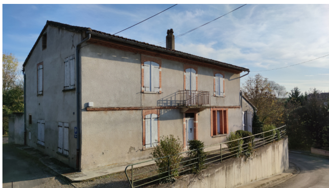
Façade principale de l'ancien presbytère AVANT réhabilitation
