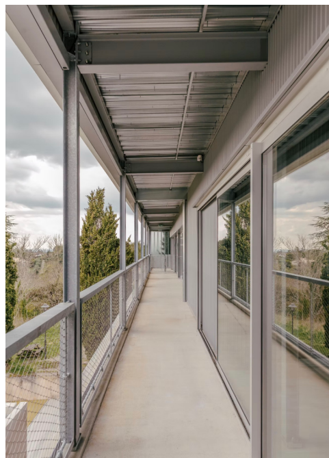
Coursive longeant la surélévation, surplombant le jardin et offrant une vue qualitative vers le paysage.
