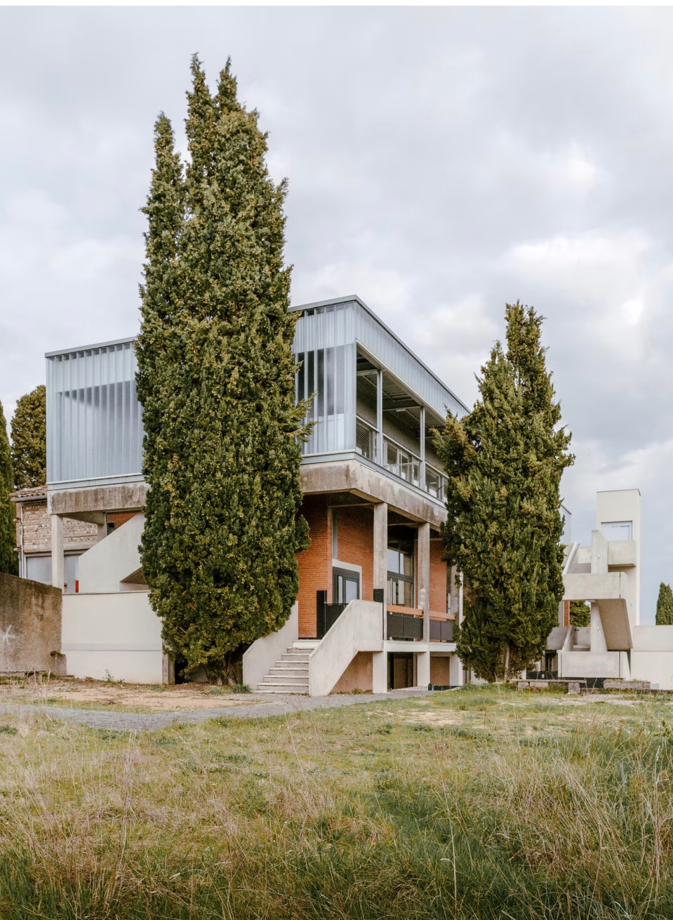
Façade arrière avec rez-de-jardin accueillant la crèche.
