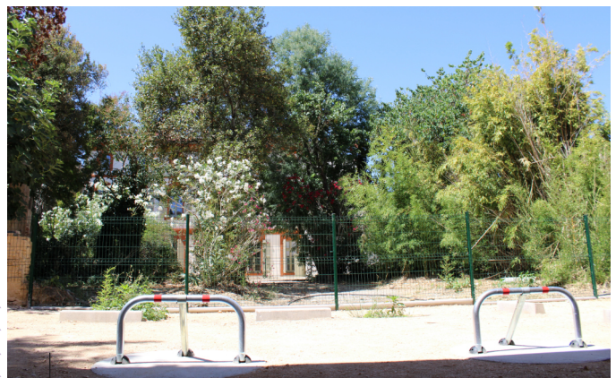
Jardin en cours de travaux, chantier réalisé par la commune
