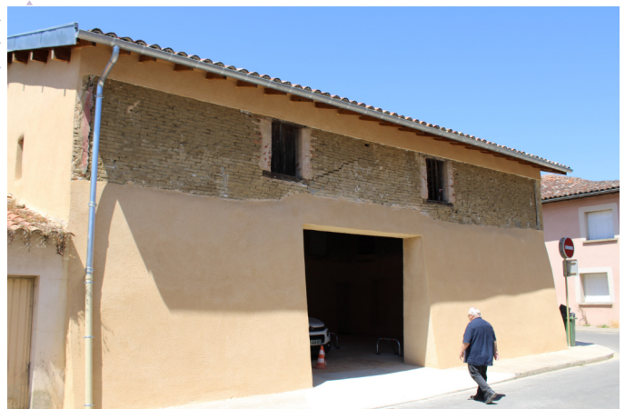
L'annexe réhabilitée pour un usage de stationnement
