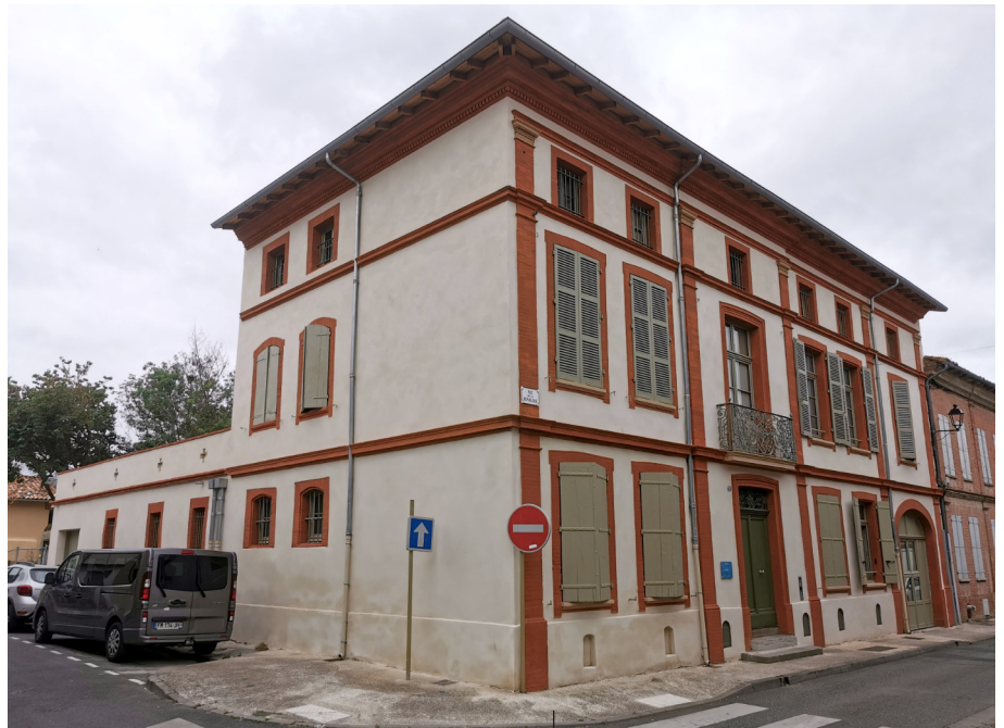
Façade principale sur la rue de la République
