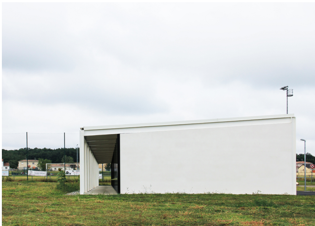
Atelier municipal : pignon et vue de la courside longeant et protégeant la façade sud
