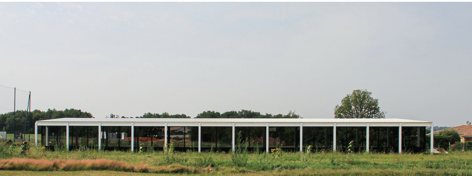
Façade sud de l'atelier municipal.
