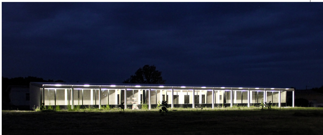
Atelier municipal : façade sud vue de nuit
