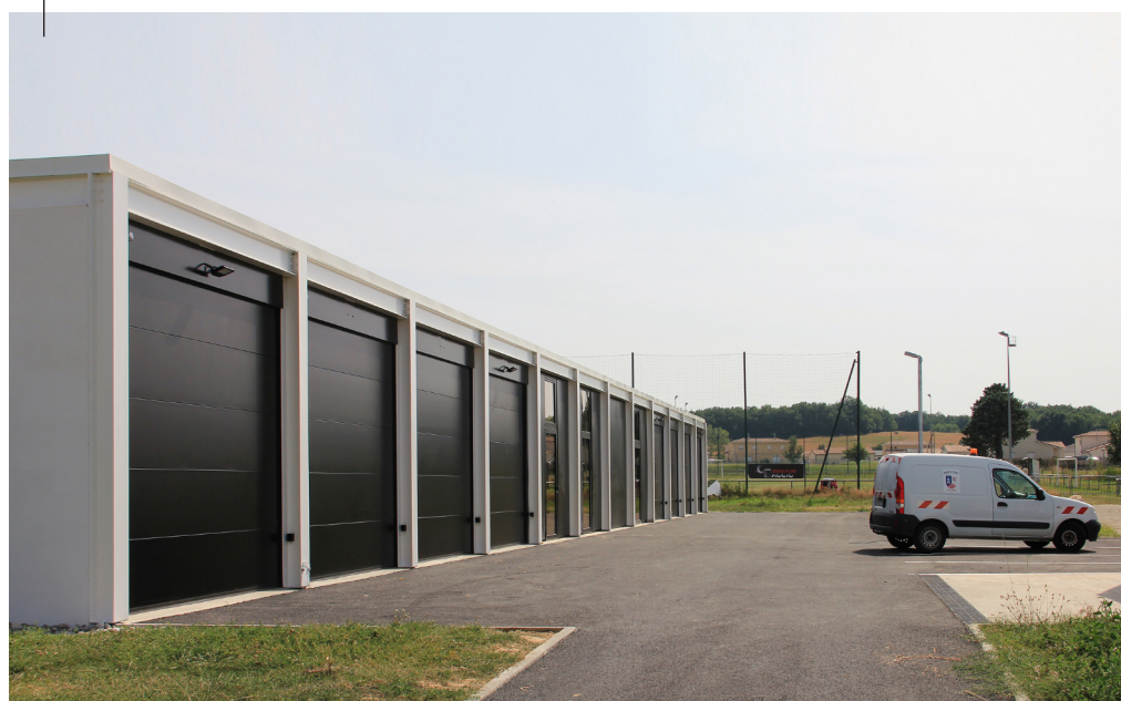
Atelier municipal : façade nord avec portes sectionnelles entre travées, aire de manœuvre et stationnement.
