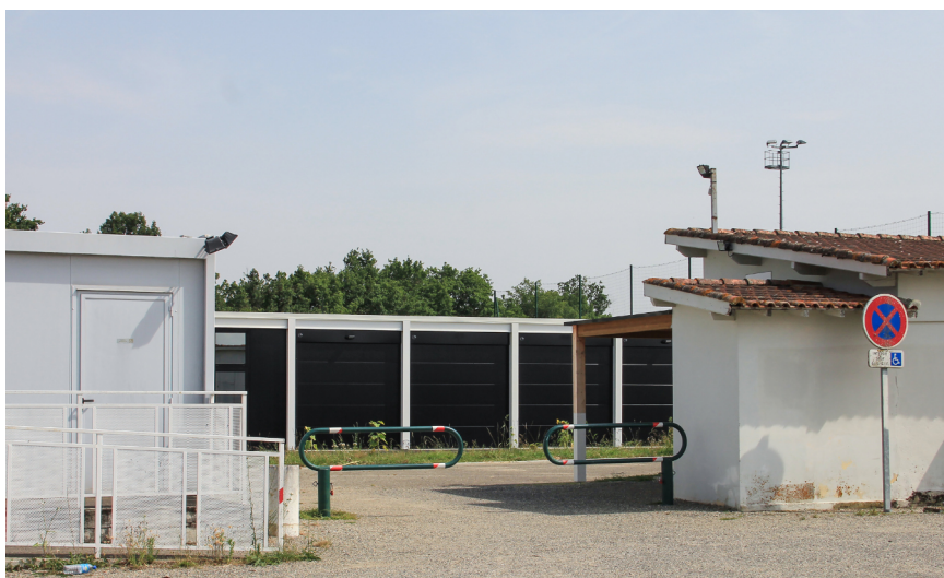
Atelier municipal façade arrière et locaux sportifs
