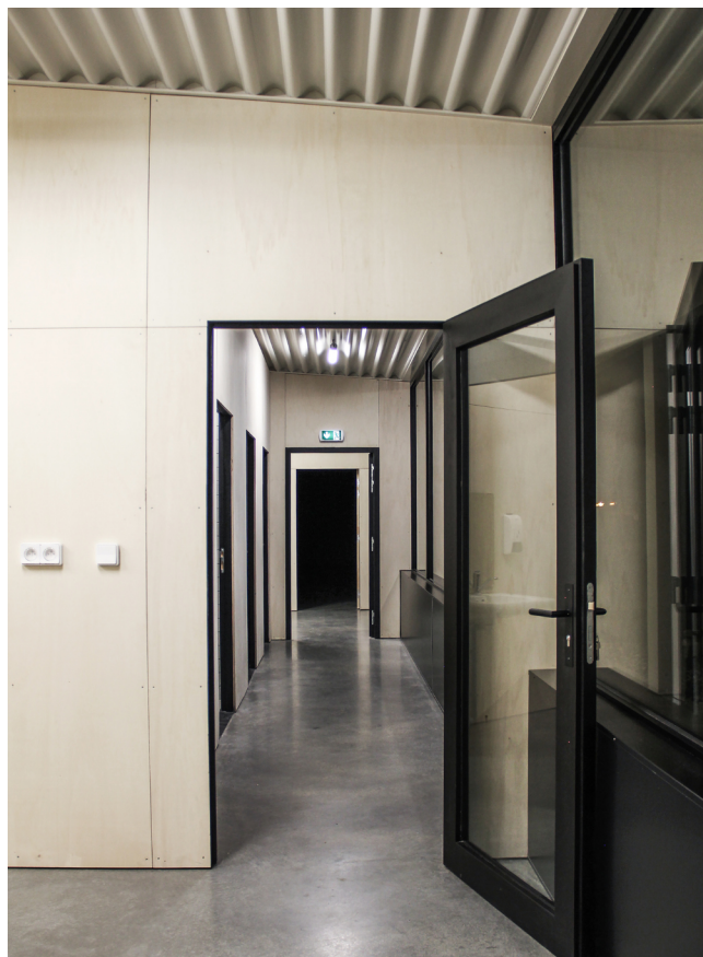
Atelier municipal : cloisonnements intérieurs
