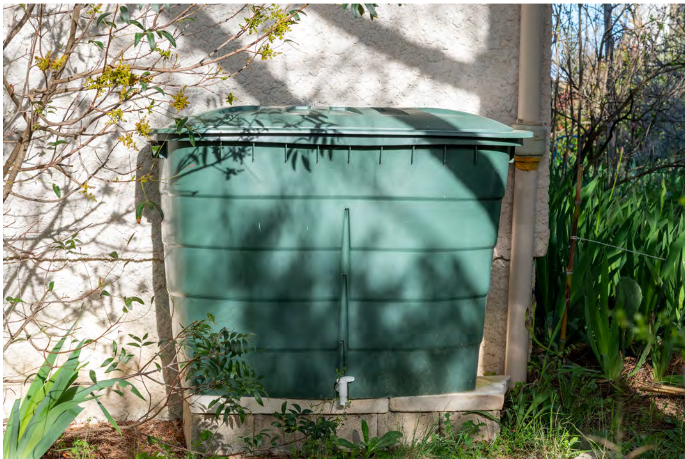
Récupérateur d'eau, périurbain de Montpellier.
