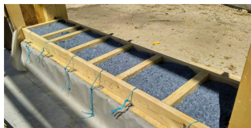
Lisse basse en bois isolée avec du coton recyclé Credit photo : Rosny-sous-Bois
