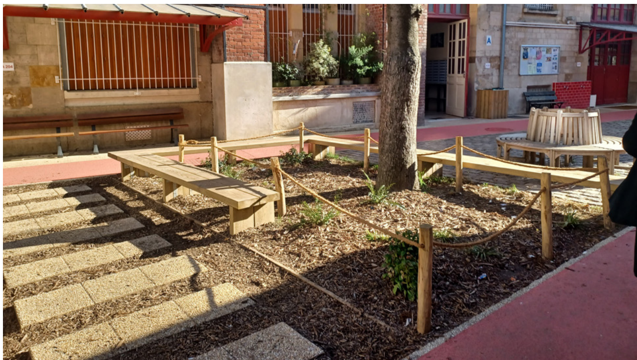
Poteaux et corde de protection dans un collège. / Camille Savage, Plante & Cité
