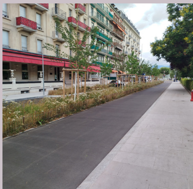
Aménagement de pieds d'arbre permettant de collecter les eaux pluviales provenant de la voirie, à Genève. / Robin Dagois, Plante & Cité
