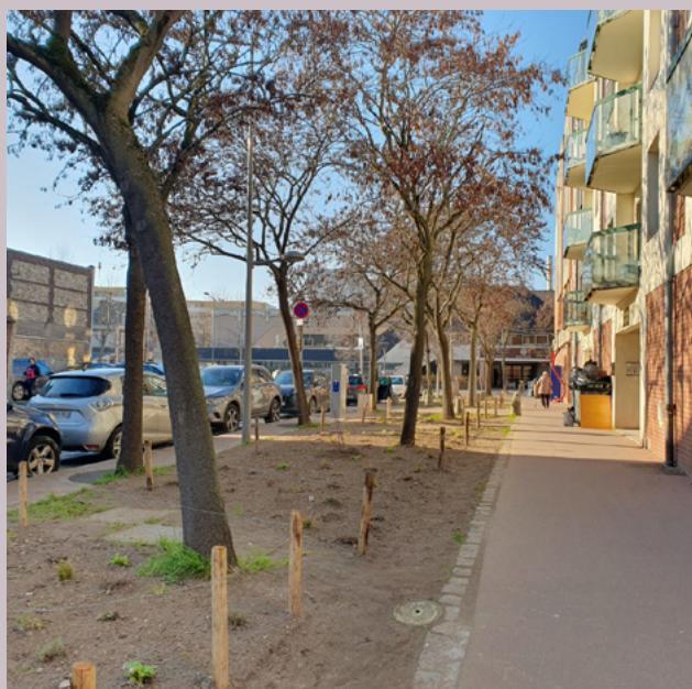
Désimperméabilisation de pieds d'arbre, à Rouen. / Anne Maquignon, Rouen Métropole
