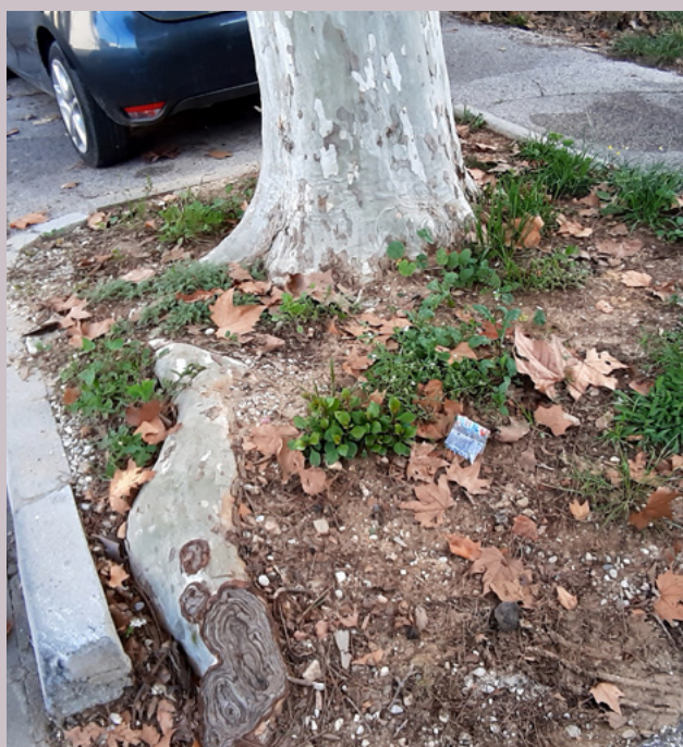
Fosse d'arbre compactée en surface, dont le volume ne permet pas le développement des végétaux. / Agathe Leleux, Plante & Cité
