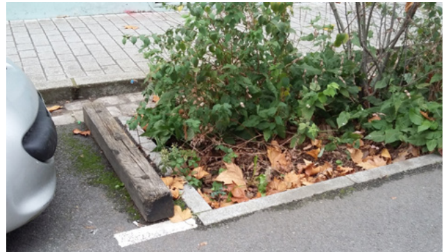
Dispositif de protection des véhicules, à Nantes. / Robin Dagois, Plante & Cité
