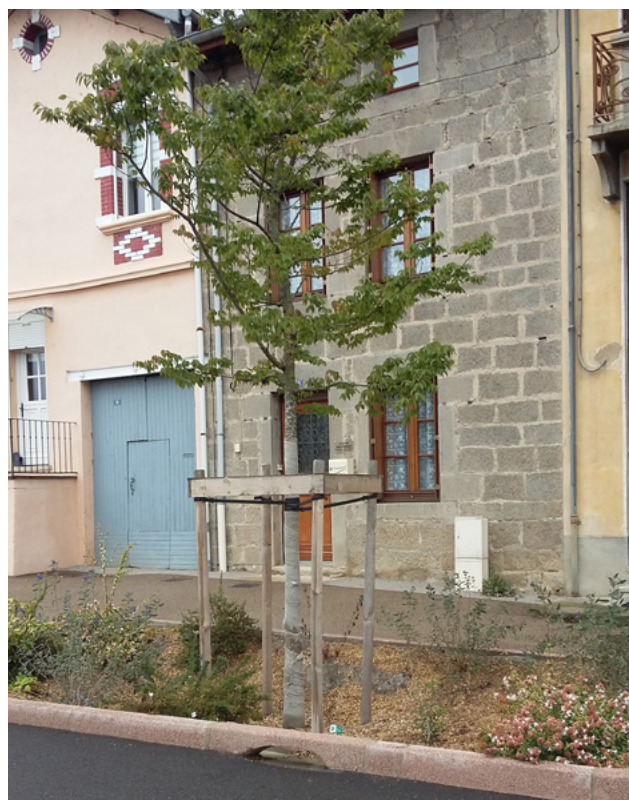
Aménagement conçu pour collecter les eaux de pluie de la voirie à l'aide d'éléments de maçonnerie permettant de laisser s'écouler l'eau vers les plantations, à Saint-Marcellin-en-Forez. / Robin Dagois, Plante & Cité
