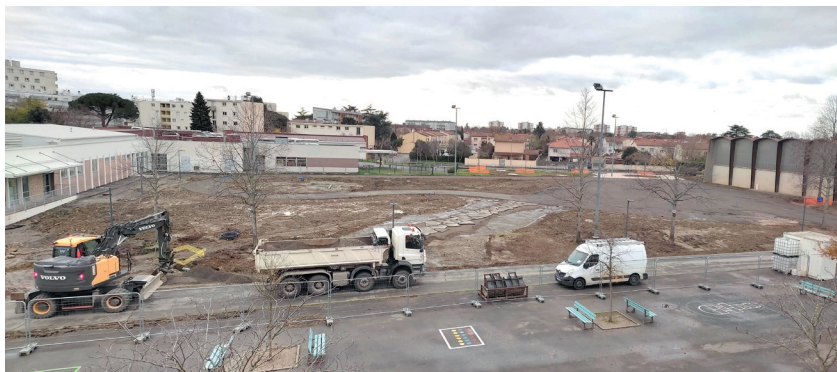
Phase de chantier en site occupé sur le plateau sportif : décroûtage de l'enrobé existant et création des îlots végétalisés. Maintien de l'usage de la cour sur la partie nord.
