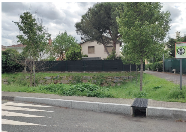
Bassin d'infiltration en point bas du quartier Renoir. Le profil de voirie retravaillé en creux pour collecter les eaux de ruissellement joue le rôle de « ralentisseur à l'envers ».
