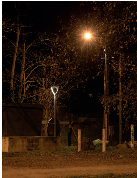
Parking de la RNR : l'éclairage LED n'a pas d'utilité. Le lampadaire SHP est trop puissant. Extrait du rapport Athena-Lum.
