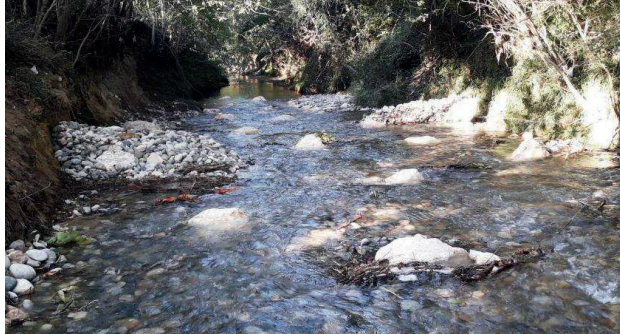
Zone de recharge en amont du bourg, après les travaux réalisés en 2023. ©SYGESave - F. BOUTEIX
