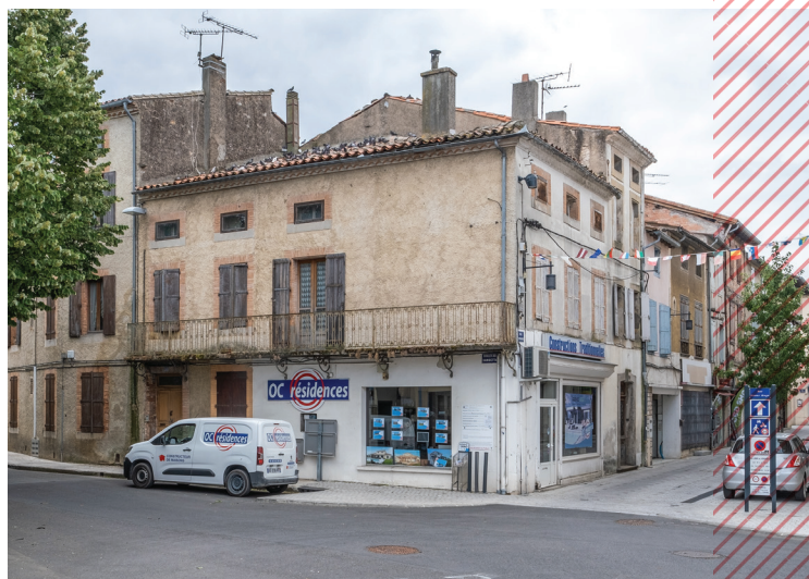
État initial du bâti © EPFO
