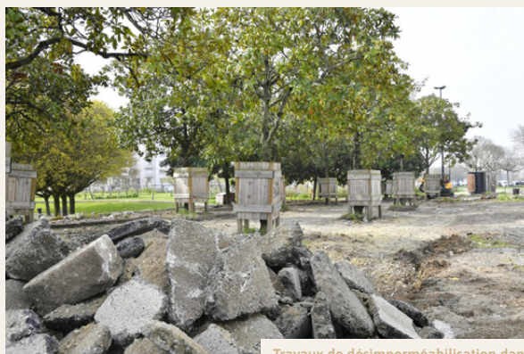
Travaux de désimperméabilisation dans le cadre du plan Pleine terre au sein du square Jean-Baptiste-Daviais (Nantes). / Nantes Métropole
