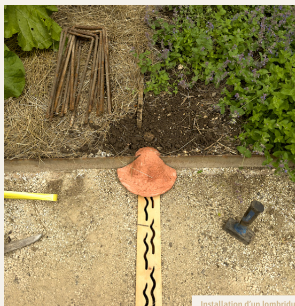
Installation d'un lombriduc dans la ville de Nancy. / Harter S., ville de Nancy
