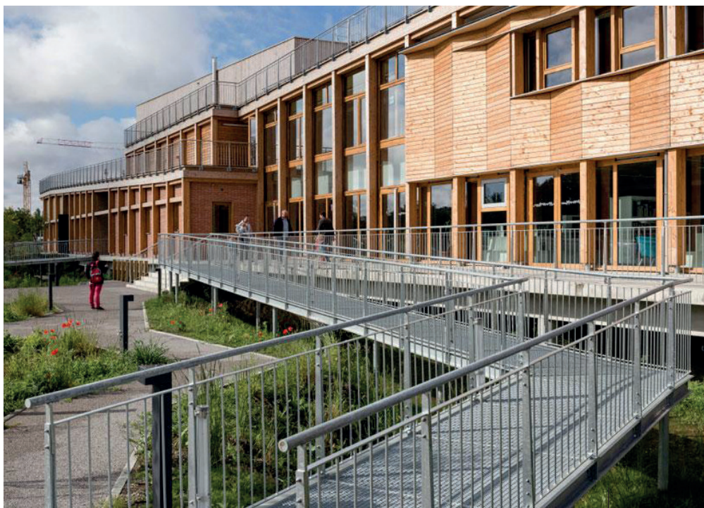
Rampes, escaliers, passerelles s'enchaînent et s'enroulent autour du bâtiment jusqu'à la toiture
