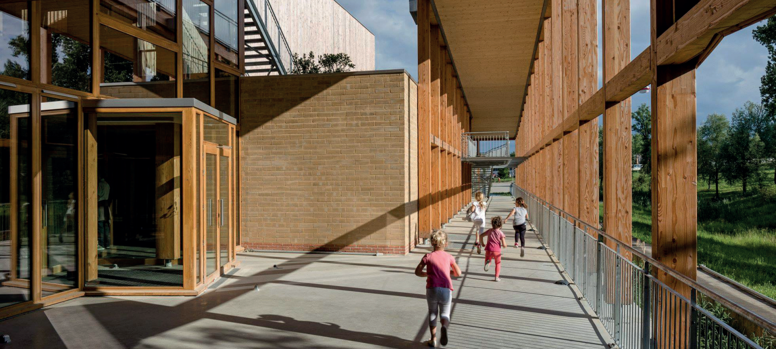
Corridor d'accès extérieur depuis la ZAC: brique de terre cuite, brique de terre crue, bardage bois, unis par une ossature bois, chaque élément de la façade reflète les caractères du paysage.
