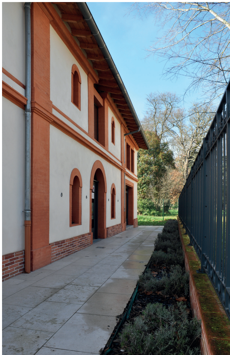
Façade Est du bâtiment
