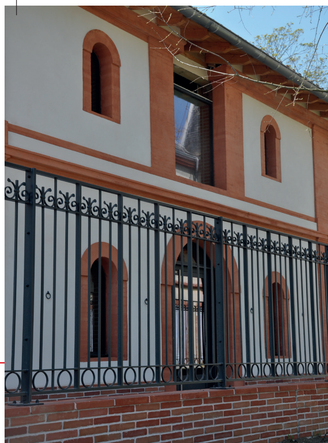
Détail de la façade Est
