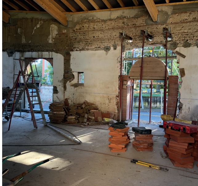
Vue de la phase chantier et reprise des ouvertures
