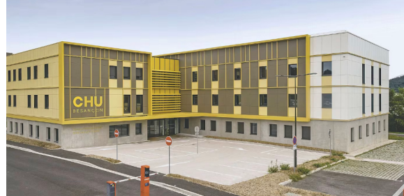
Centre soins dentaires à Besançon, assemblage de 73 modules bois préfabriqués / CCR Architecture Credit photo : Jack Varlet
