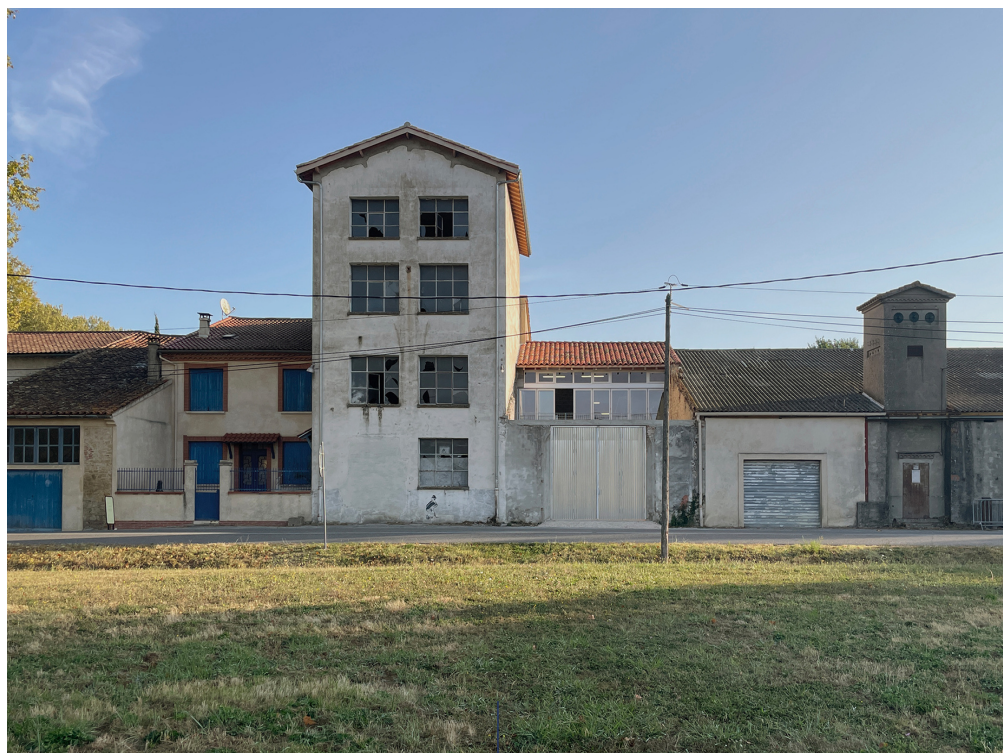
Façades arrières par rapport au Canal du Midi
