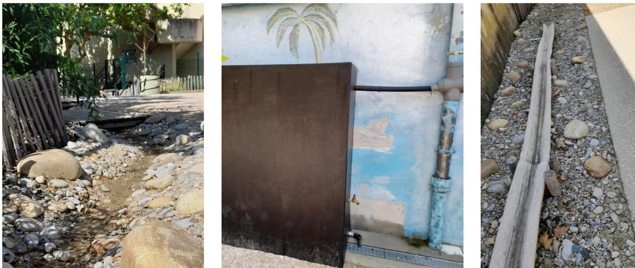
Figure 13 – Ruisseau alimenté par une cuve de récupération d'eau de pluie dans la cour de l'école du Château à Chasse-sur-Rhône (38) – ©Cerema
