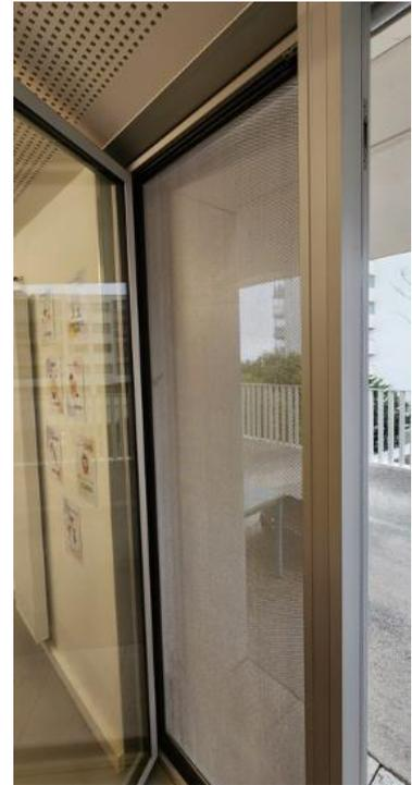
Figure 25 – Ouvrant de ventilation équipé d'une grille métallique anti-intrusion dans une école à Cannes (06) – ©Cerema
