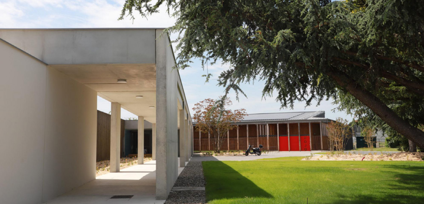
Vue sur la galerie d'entrée, le parvis et le Dojo
