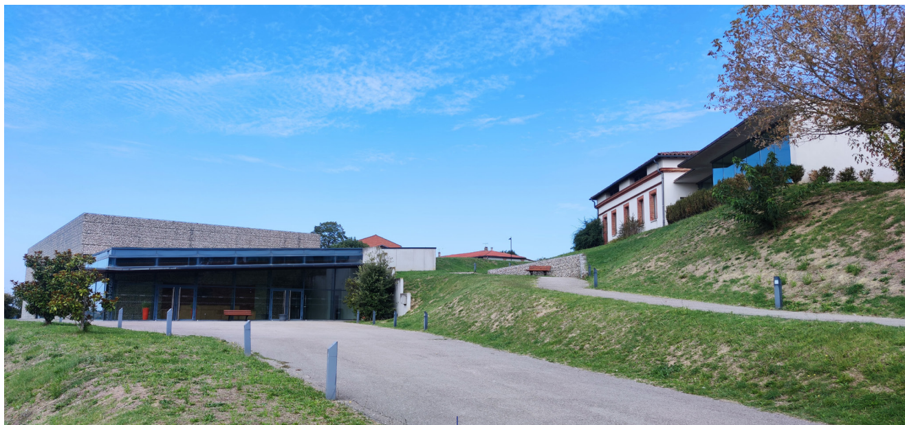
La nouvelle salle des fêtes et la mairie étendue en haut de pente
