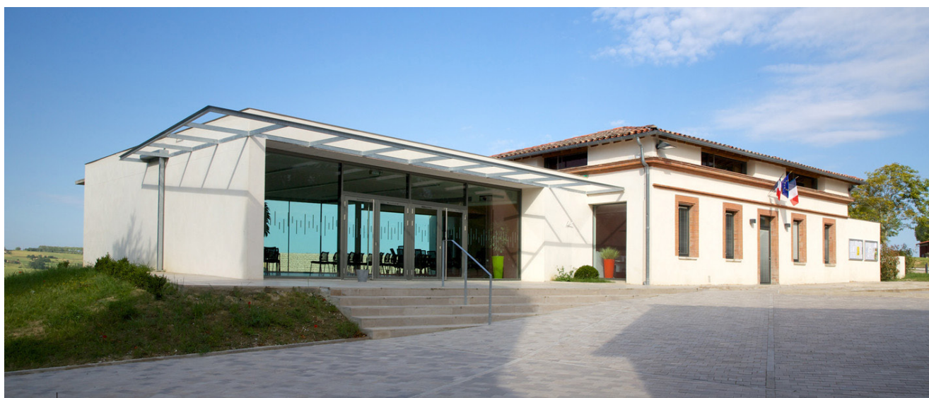
Extension verticale et horizontale de l'ancienne maison de village, emmarchement devant la salle du conseil qui s'adapte à la déclivité
