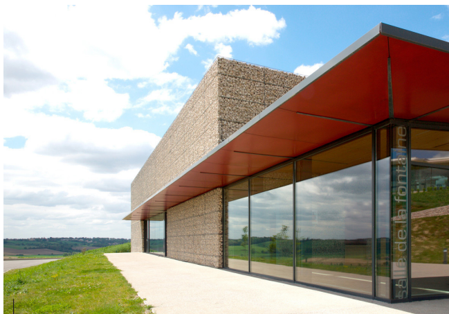
La vêtue en gabions et les baies vitrées protégées de larges débords de toiture
