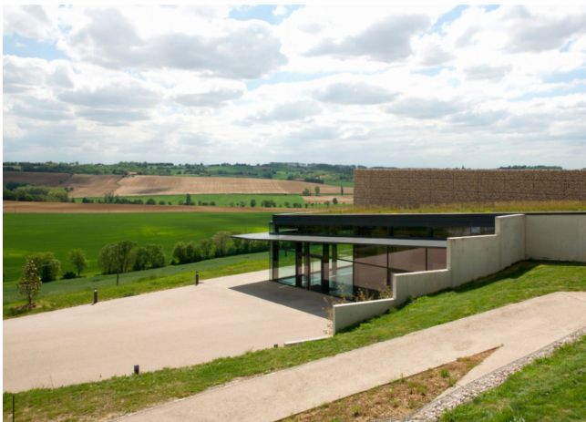
Réalisation d'un cheminement dans la pente pour relier les équipements
