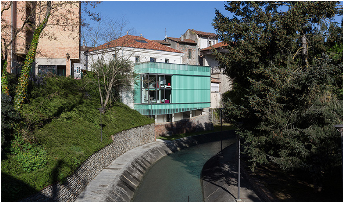
Extension en façade Est en surplomb sur l'Hourride
