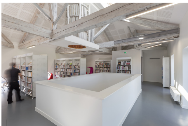
Ambiance intérieure, mise en valeur du ventilateur en lames de châtaignier intégré à la charpente
