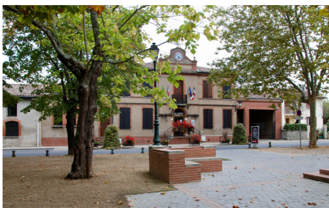
Mairie avant travaux / source : atelier-atp.com
