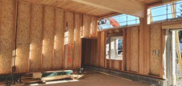
Ossature bois interieure (chantier)
