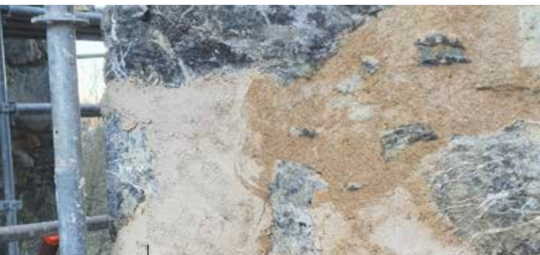
Essais enduit chaux (chantier)
