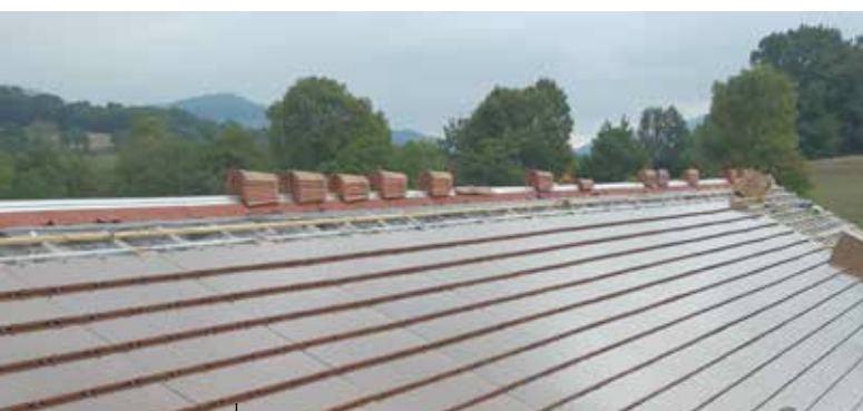
Pose des panneaux photovoltaïques rouge (chantier)
