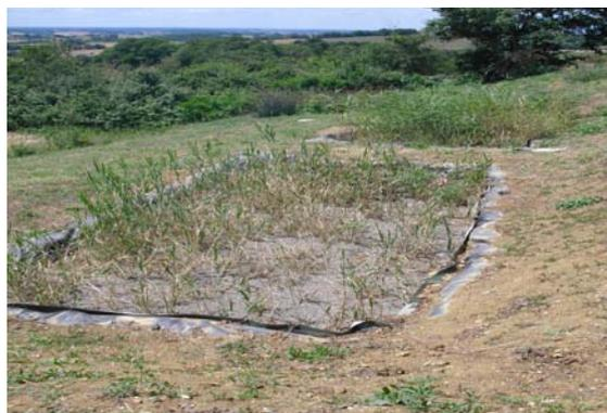
Premier niveau de traitement aérobique planté de roseaux. Étanchéité du bassin réalisée avec une géomembrane EPDM.
