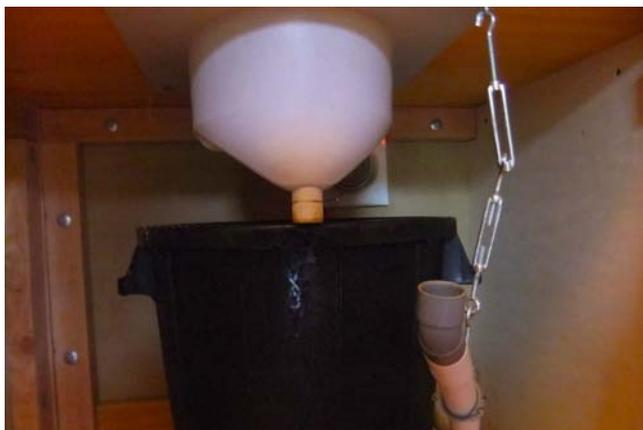
*Vue du dessous de la lunette séparative avec raccordement aux urines et réceptacle des résidus de toilettes sèches. Le caisson est étanche et ventilé.*
