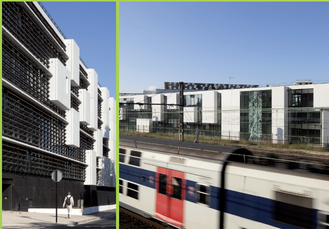
Vue de la façade Sud côté autoroute et de la façade Nord-Est depuis la voie ferrée
