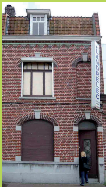
Vue d'une façade restaurée sur rue
