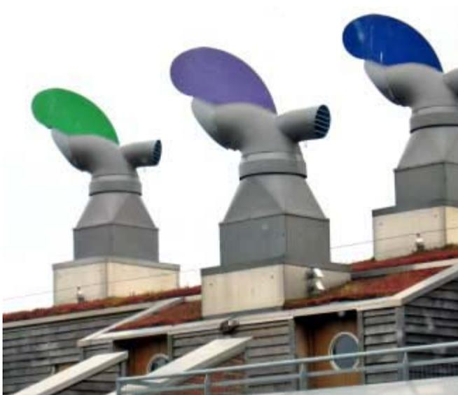
Un système de cheminées, fonctionnant avec la seule énergie du vent, assure la ventilation des logements et garantit ainsi un bon renouvellement de l'air intérieur. L'air qui sort de ces bâtiments à isolation thermique renforcée chauffe celui qui entre -avec une récupération de 50 à 70% des calories provenant de l'air vicié évacué- grâce à un échangeur de chaleur intégré. Le haut des cheminées, en forme de capuchons abat-vent très colorés, symbolise le projet BedZED.
