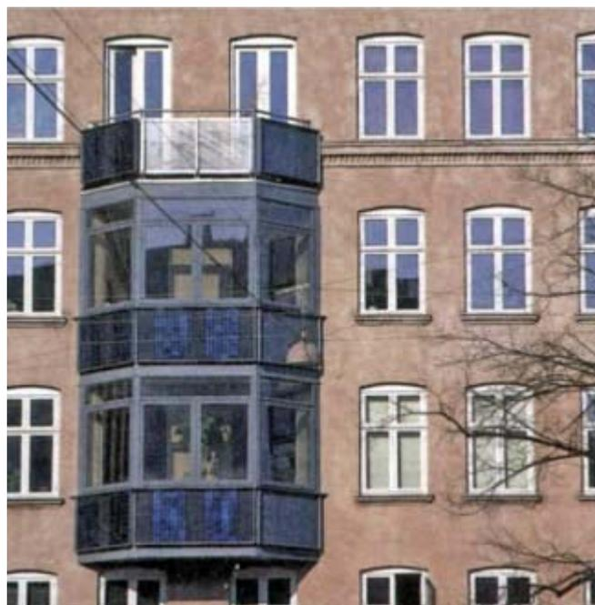
D'une épaisseur de 25 cm, ces façades en vitrages à haute performance thermique améliorent l'isolation des immeubles. Afin d'y intégrer les panneaux photovoltaïques, des verrières ou des balcons ont été aménagés, sous forme de bow-windows agrémentés d'allèges en panneaux photovoltaïques, par exemple.
