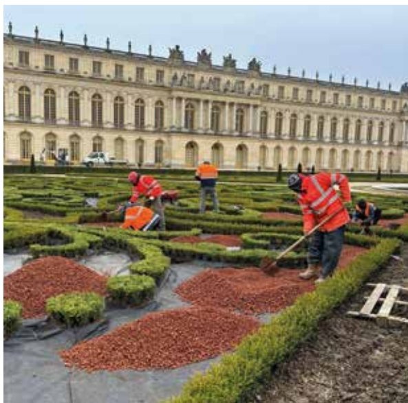
▲ Restauration du Parterre du Midi au Château de Versailles © Patrick Salembier
