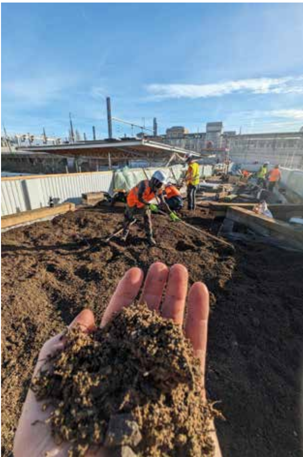
Le substrat est fabriqué à partir des terres excavées des chantiers du Grand Paris © Topager
