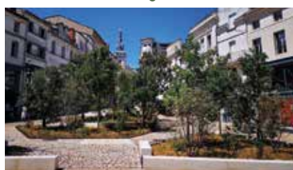
La même place, après désimperméabilisation et végétalisation
