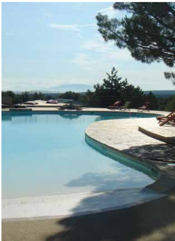
Un lagon en résine béton-désactivé © V Egon
