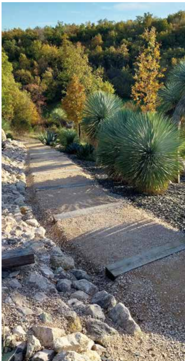
Aménagement de gradines
