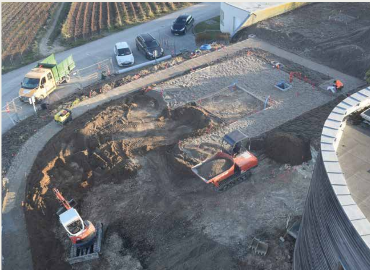
Le phare de Verzenay pendant les travaux
