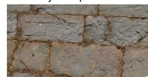
Dalles dégradées en pierres calcaires, joints non poreux
