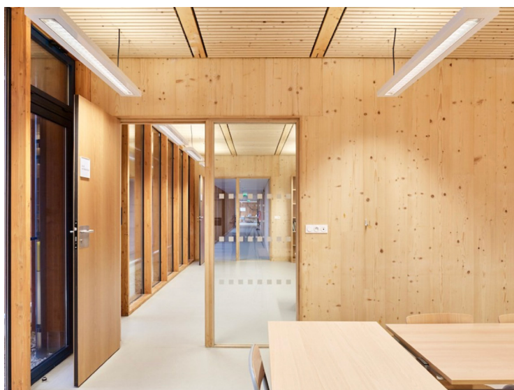
Détail des murs porteurs CLT
