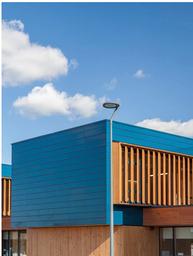
Entrées de lumières naturelles avec dispositif de lames mobiles
