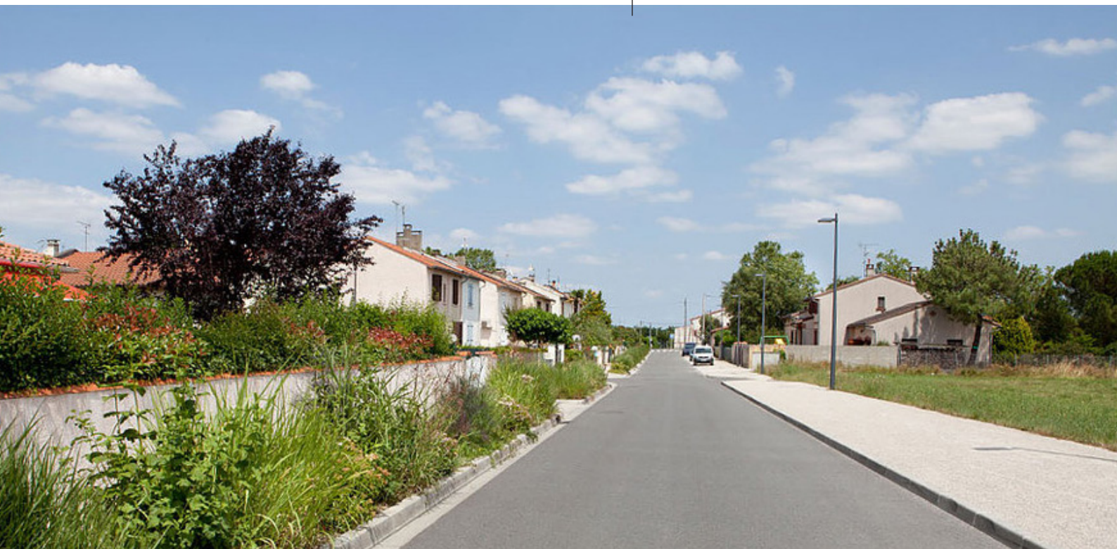
Aménagement du chemin de Montagne
