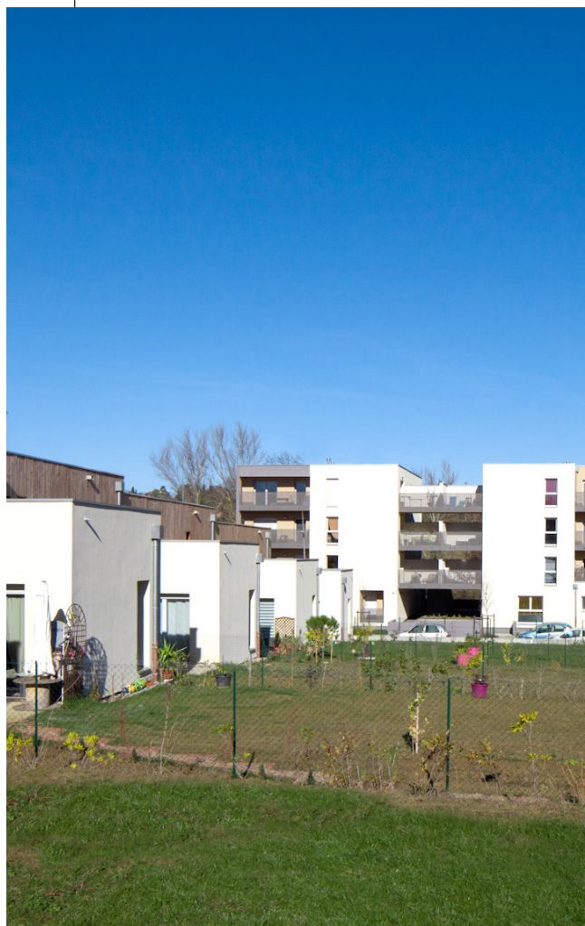
Vue sur les façades arrières et les jardins
