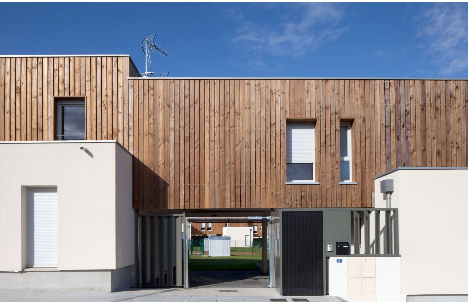
Vue de façade sur rue
