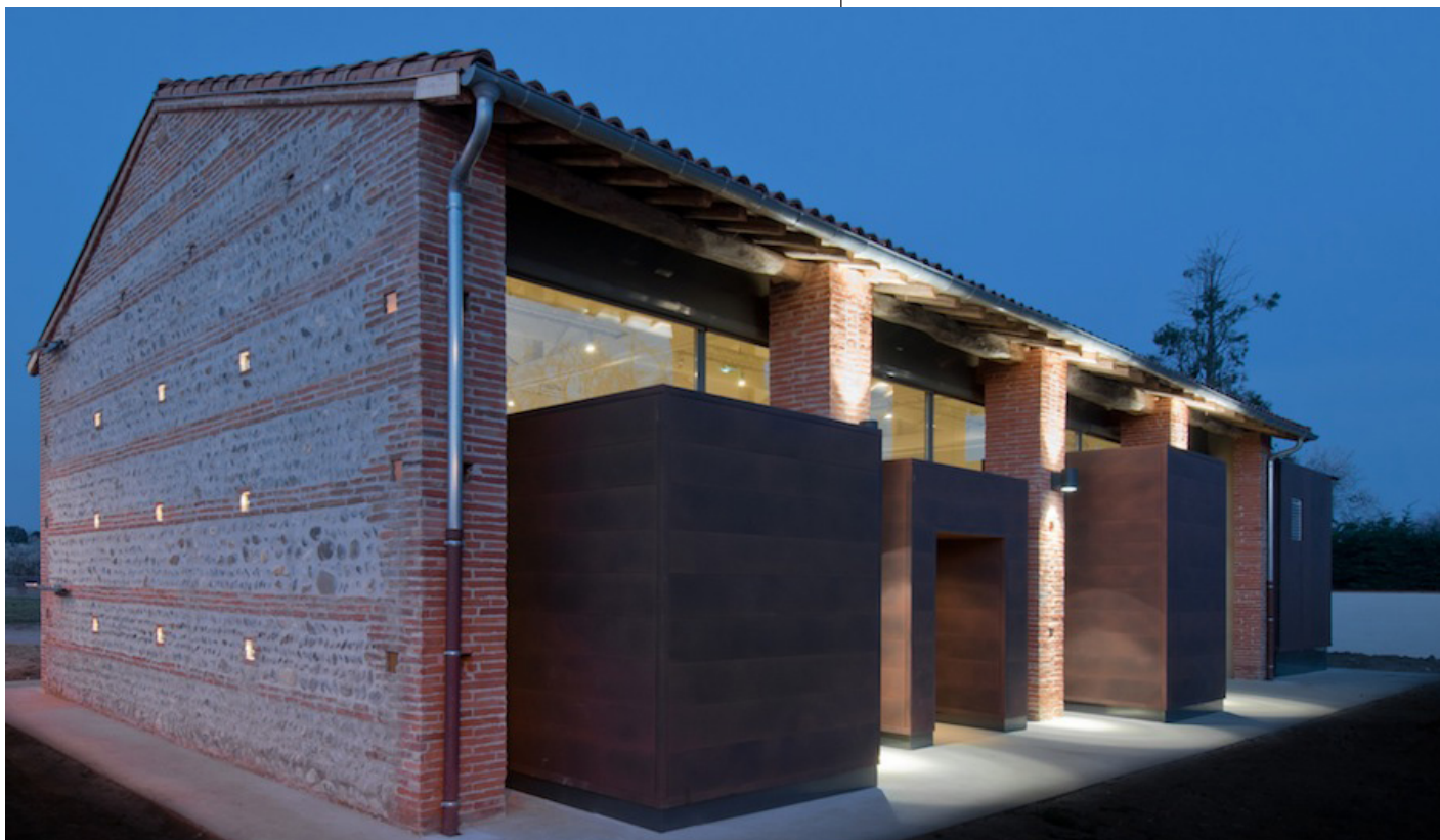
Façade avec éclairages de nuit
