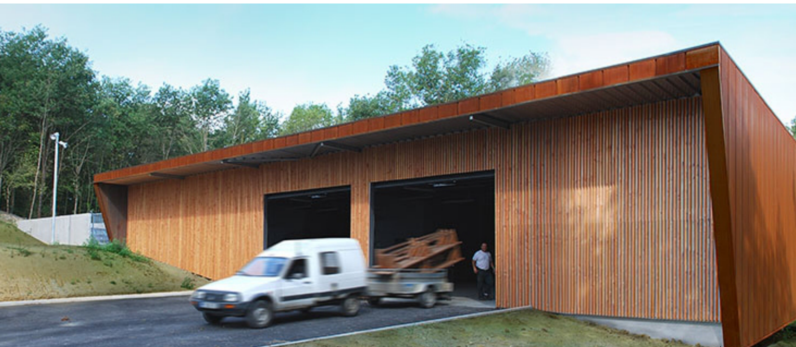
Vue de l'entrée avec façade latérale en acier Corten
