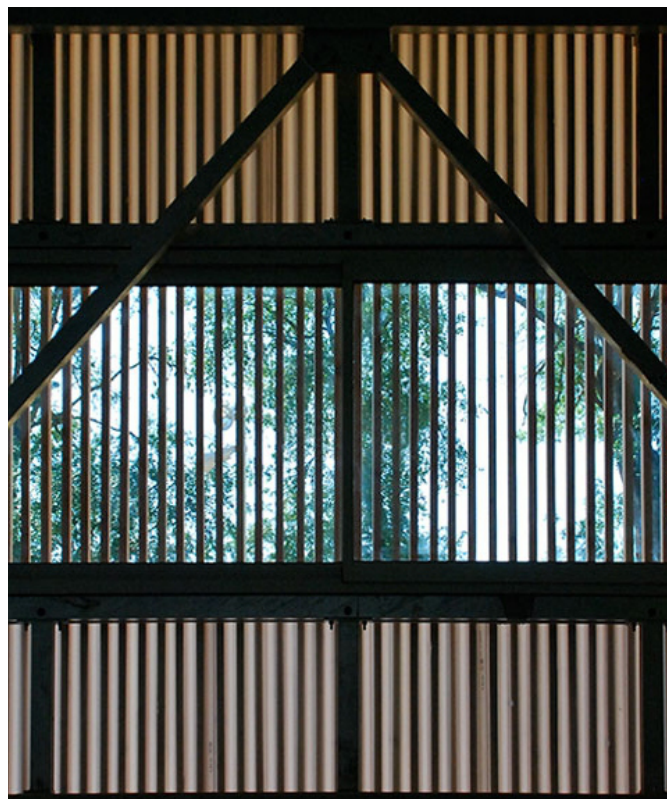
Bardage bois vu de l'intérieur
