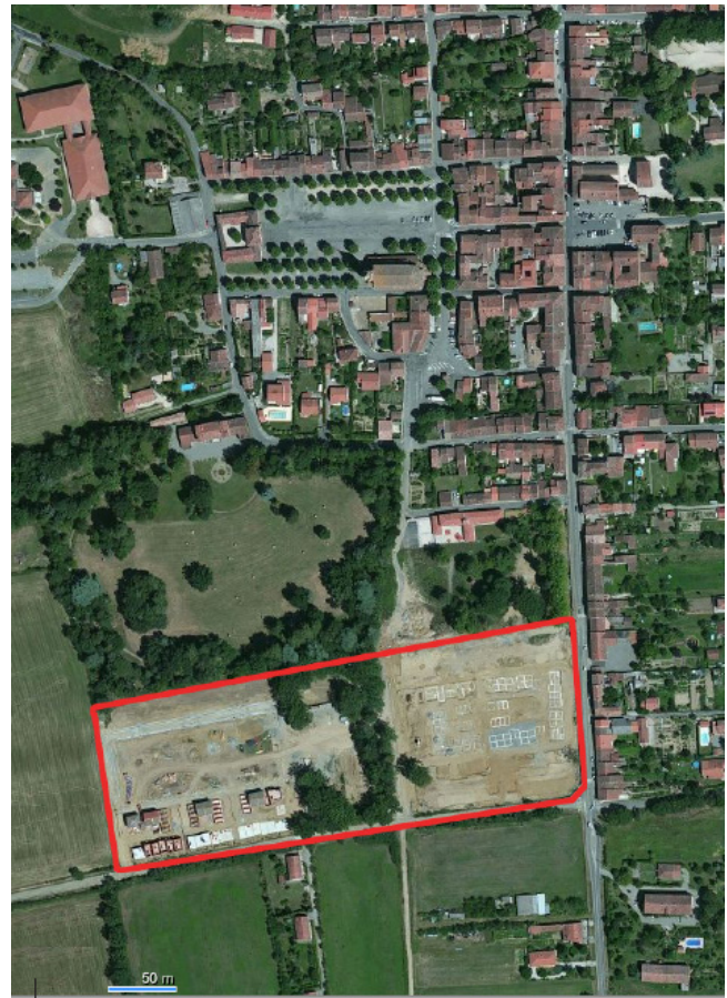
Vue aérienne de la parcelle en cours de travaux.
