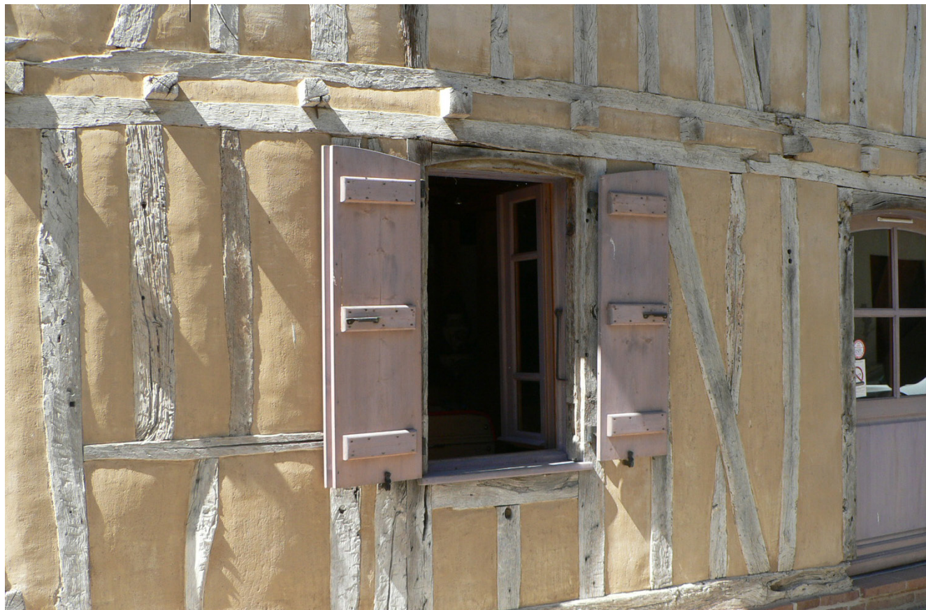
Façade à pans de bois et remplissage torchis
