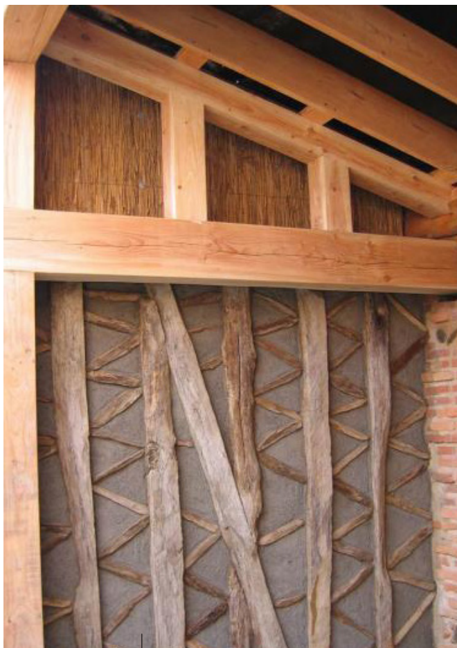
Enduits colombages et roseaux
