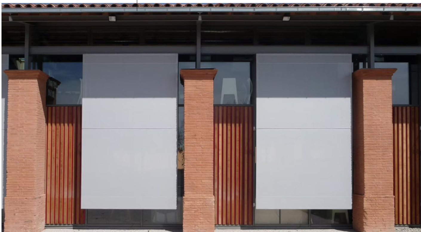
Vue de la façade
