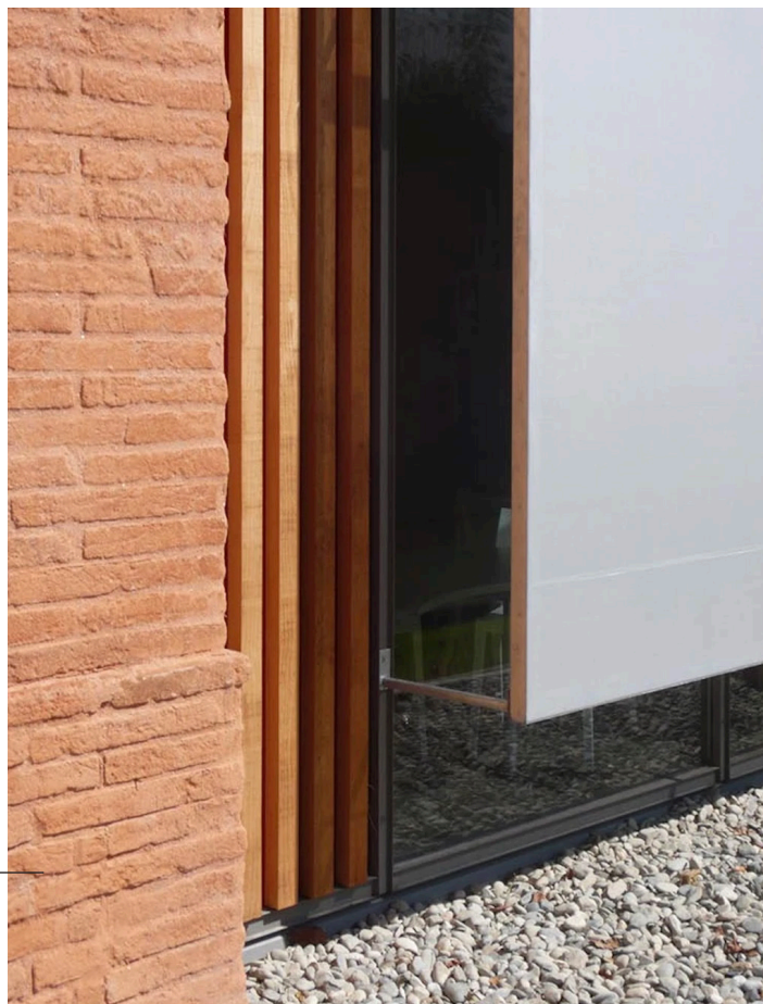
Détail de la façade
